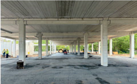
Depozitní část tvoří montovaný železobetonový skelet, realizace tedy postupuje rychle.
