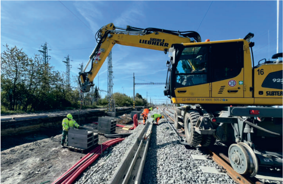
Vedle samotných kolejí pracuje divize 3 na souvisejících technologických objektech, ke kterým patří odvodnění a kabelové chráničkové trasy.
