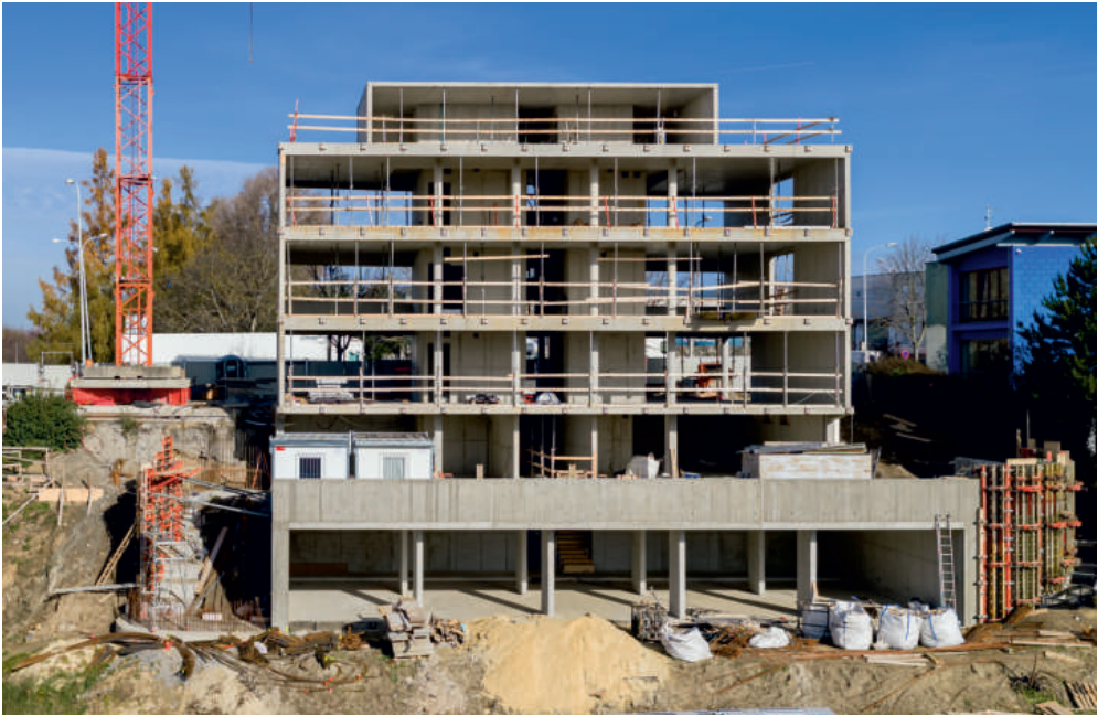
Po dokončení monolitické nosné konstrukce je dobře patrná členitá silueta budovy. Hlavní, třípodlažní hmotu doplňují dvě různě velká suterénní podlaží a ustupující nejvyšší patro.
