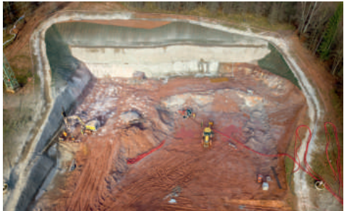
Jižní portál tunelu Opevnění je již téměř připraven na zahájení ražeb.
