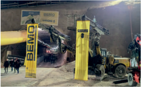
V prostoru před portálem si přítomní mohli prohlédnout stavební stroje.
