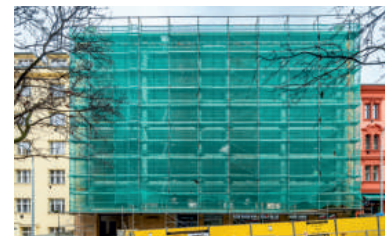
BYTOVÝ DŮM SUDOMĚŘSKÁ
