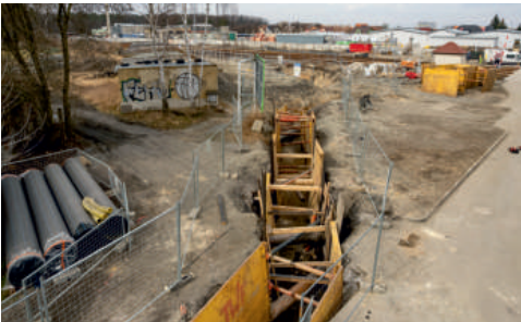
Přeložky inženýrských sítí vyžadují rozsáhlé výkopové práce.
