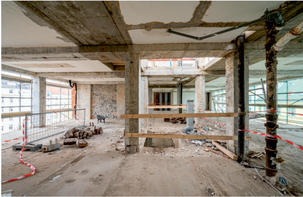
V první fázi rekonstrukce prováděla divize 2 převážně demoliční práce, po nichž z původní budovy zbyl pouze železobetonový skelet.
