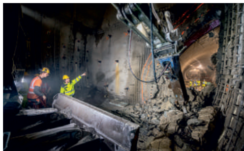
Průběh prorážky s napojením různých profilů bylo třeba neustále kontrolovat.
