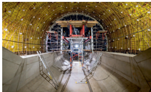
Ražba i betonáž přestupního eskalátorového tunelu vyžadovala pečlivé plánování.
