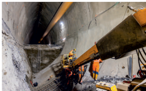
Při ražbě dna dílčích výrubů se zčásti odhaluje primární ostění patní štolý.
