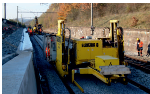
Při realizaci kolejí se uplatňují portálové pokladače a dvoucestné bagry.
