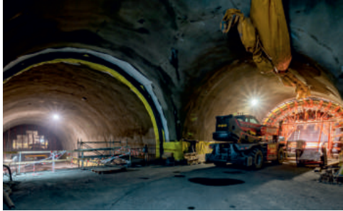
V technologickém bloku sever a strojovně vzduchotechniky jsou realizovány hydroizolace.
