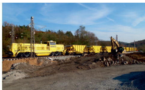
Práce na železničním spodku a svršku vyžadují přepravu velkého množství zemin a štěrku.
