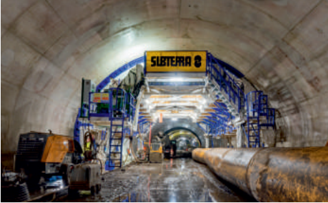
Za stanicí Pankrác D je betonováno sekundární ostění obratového tunelu.
