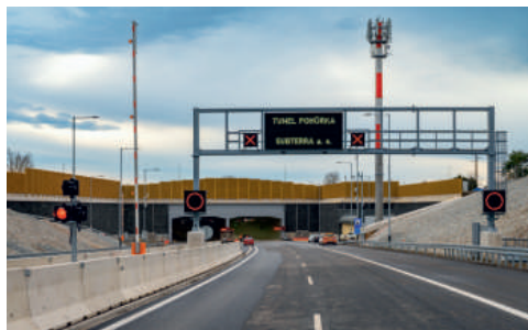
Dvoutubusový hloubený tunel Pohůrka má délku téměř jeden kilometr.
