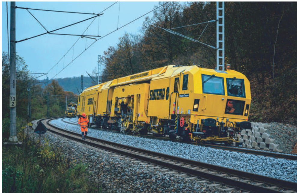
Při rekonstrukci 1. traťové koleje i na dalších součástech projektu využívá divize 3 svoji mechanizaci včetně automatické podbíječky a pluhu pro úpravu kolejového lože.
