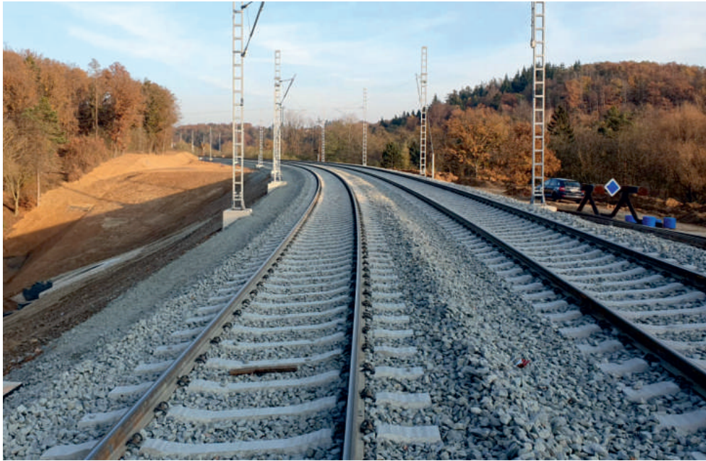
Spolu s výstavbou trakčního vedení představuje největší přínos projektu vybudování druhé koleje, které vyžadovalo rozsáhlé práce při rozšíření náspu a zářezech do svahů.
