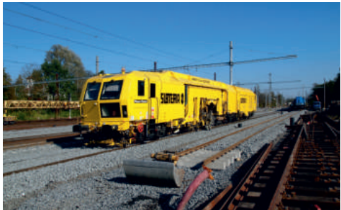
Při realizaci železničního svršku je využívána také automatická strojní podbíječka.
