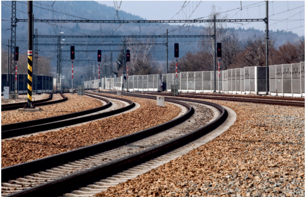
K postupně optimalizovaným koridorovým tratím s traťovou rychlostí až 160 km/h patří například úsek III. tranzitního železničního koridoru Zbiroh–Rokycany.
