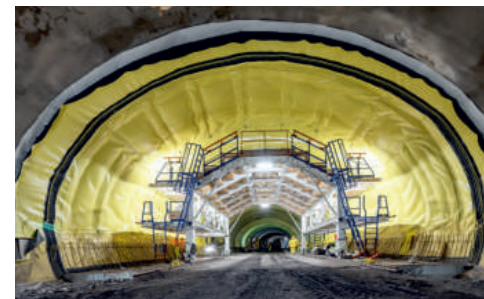
Klenba obrátového tunelu za stanici Pankrác již dostává fóliovou hydroizolaci.
