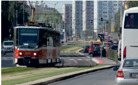
K tramvajovým stavbám divize 3 patří rekonstrukce pražské trati Evropská..
