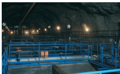
První tuzemská podzemní čistírna odpadních vod byla vybudována v Peci pod Sněžkou.
