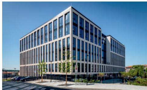
Jednou z rozsáhlých staveb v Praze byly instalace pro projekt Churchill Square.
