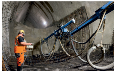
Ve stanici Pankrác pokračuje také realizace opěří levého dílčího výrubu.
