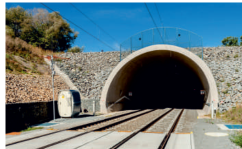
Olbramovický tunel je na trati Votice – Benešov u Prahy, jež se stala Dopravní stavbou roku 2013.
