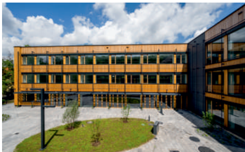
Střední škola Českobrodská v Praze byla přestavěna na energeticky soběstačnou budovu.
