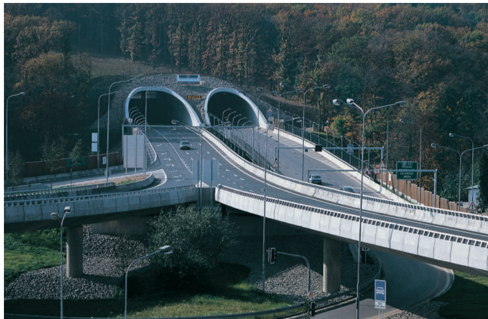
Pisárecký tunel na Velkém městském okruhu v Brně, součást Pražské radiály, razila divize 1 v druhé polovině 90. let. Stavba je prvním tuzemským městským tunelem dálničního typu.
