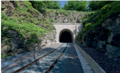
Obnova trati Trutnov – Teplice nad Metují zahrnovala i rekonstrukci Teplického tunelu.
