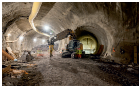
Ve stanici Pankrác probíhá ražba přestupní a eskalátorové chodby.
