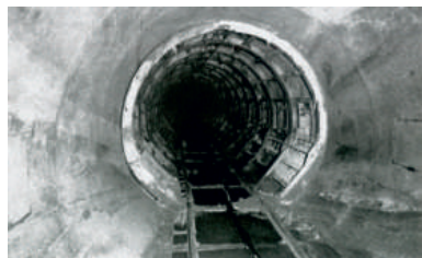
1964 – VODNÍ TUNEL ŽELIVKA
