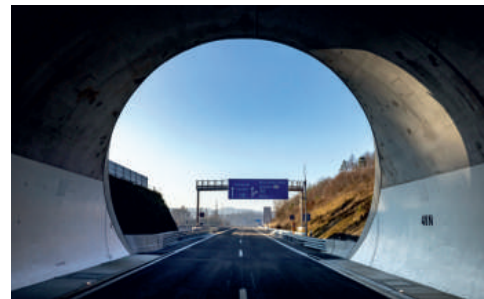
K zahraničním projektům patří tunel Herrschaftsbuck na německé dálnici A98.
