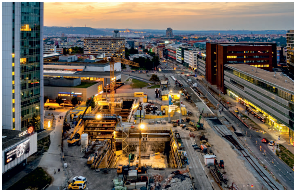
Spolu s pracemi na stanici Pankrác včetně přestupu mezi trasami C a D pokračuje výstavba podchodu a rovněž prodloužení tramvajové trati.
