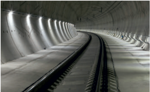
Pevnou jízdní dráhu realizovala divize 3 ve více než čtyřkilometrovém Ejpovickém tunelu.
