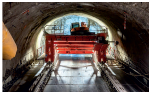
Eskalátorový tunel do vestibulu Gemini je ražen dovrchně ze stoupací plošiny.
