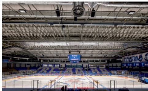
Divize 4 se podílela na celkové rekonstrukci ČEZ zimního stadionu v Kladně.
