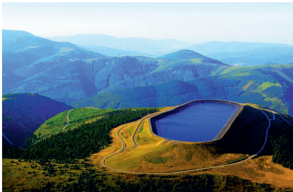
Přečerpávací vodní elektrárna Dlouhé stráně, považovaná za technický div Česka, využívá půlkilometrového výškového rozdílu mezi horní a dolní nádrží.
