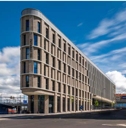
TZB při výstavbě hotelu The Cloud One, Praha The Cloud One Hotel, Prague – Subterra implemented Service Systems
