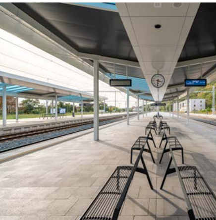
Optimalizace železniční trati Praha-Vysočany – Mstětice Railway line upgrade, Section Prague-Vysočany – Mstětice
