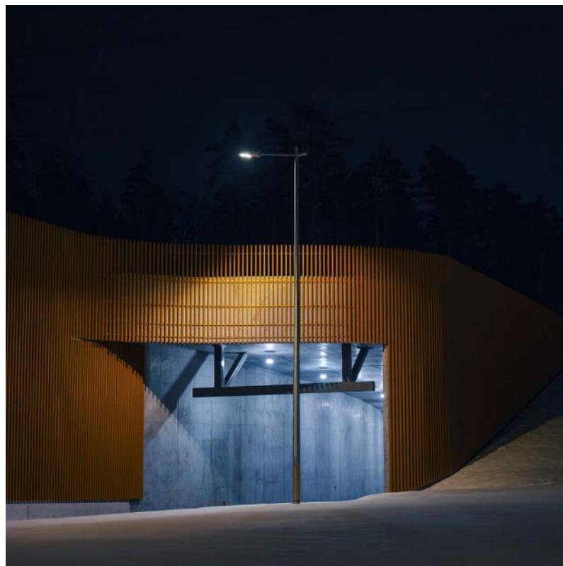
Výstavba tunelu Skarholmen, Stockholm Construction of the Skarholmen tunnel, Stockholm
