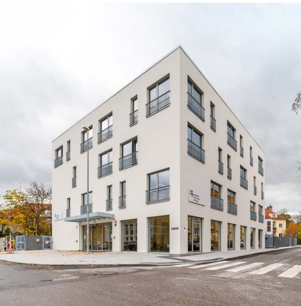
Výstavba objektu městské knihovny, Praha Construction of the building of the Municipal Library, Prague
