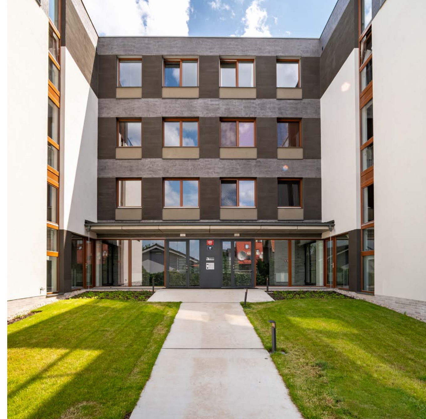
Výstavba bytového domu Pod Menhirem, Praha Construction of the Pod Menhirem apartment building, Prague
