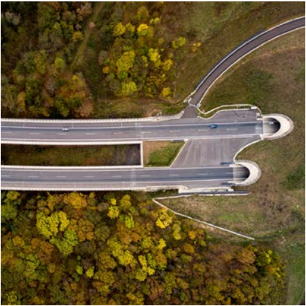
TZB při výstavbě tunelů Prackovice, Radejčín na dálnici D8 Prackovice, Radejčín Tunnels on the D8 motorway – Subterra implemented Service Systems
