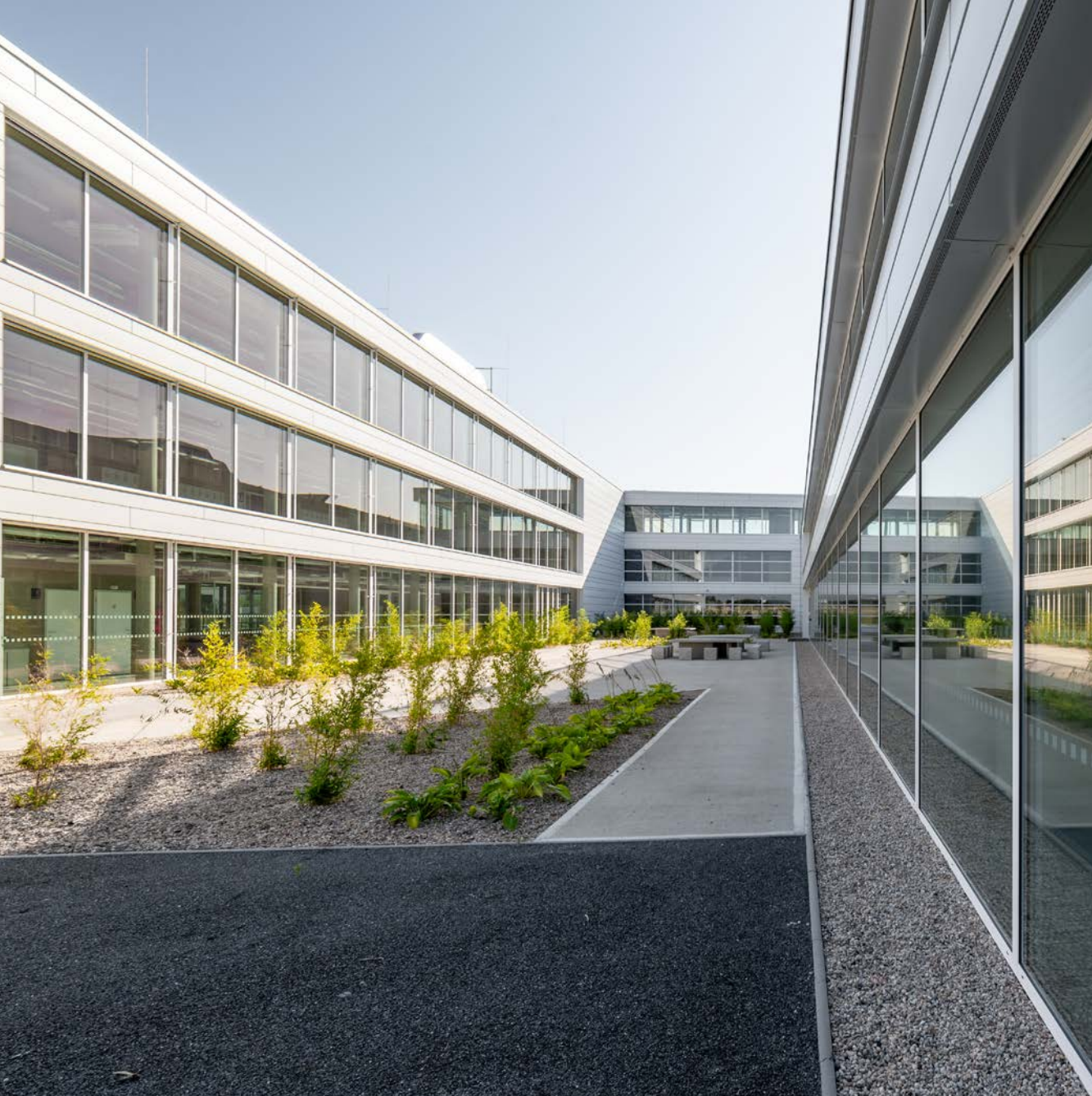
Výstavba areálu svazkové základní školy, Přezletice Construction of the elementary school complex, Přezletice
