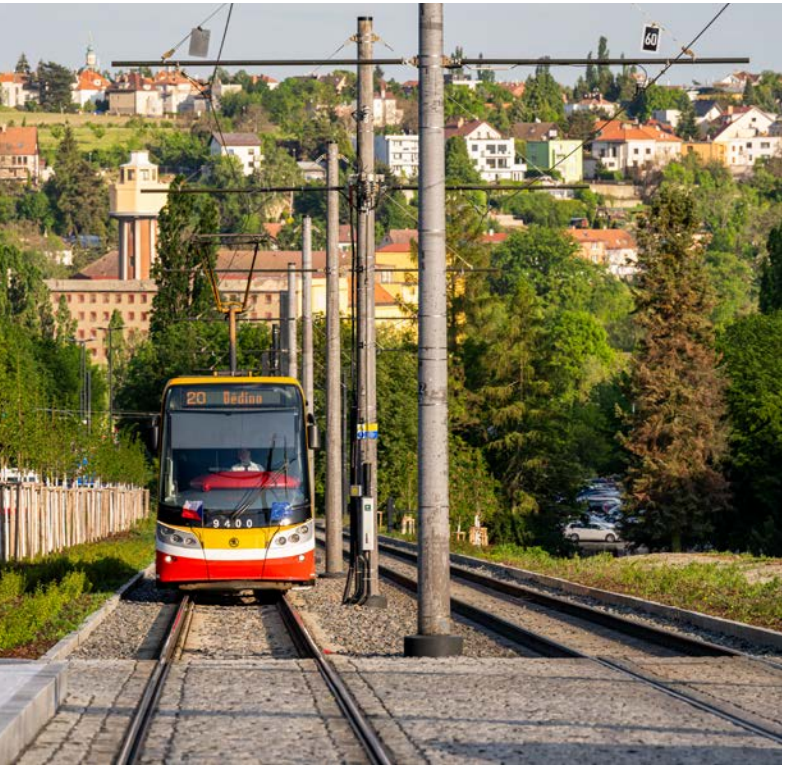
Výstavba tramvajové trati Divoká Šárka – Dědina, Praha Construction of the tram line 'Divoká Šárka – Dědina, Prague
