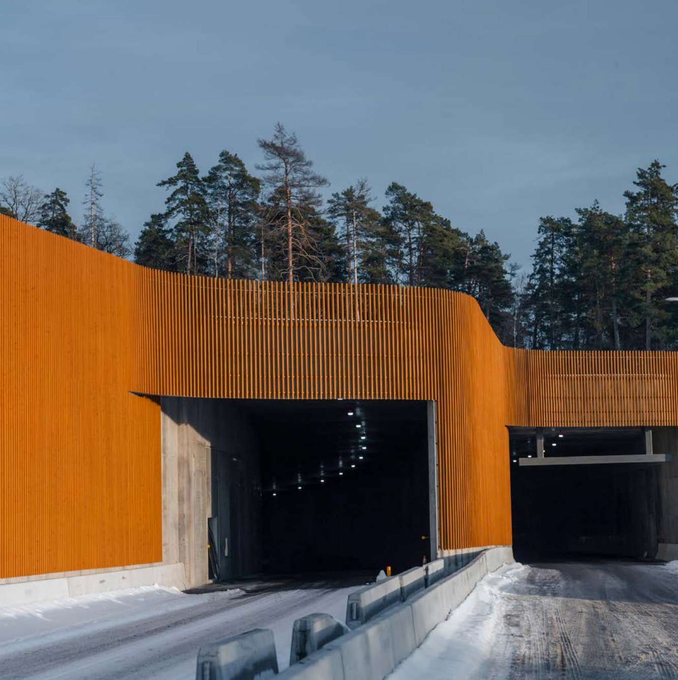
Výstavba tunelu Skärholmen, Stockholm Construction of the Skärholmen Tunnel, Stockholm
