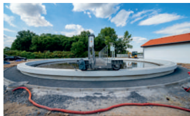
ČOV V BRANDÝSE NAD LABEM
