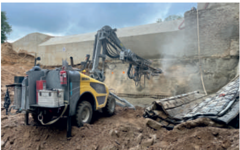
Na stavbě je nasazena nová lomová vrtačka s rotátorem Epiroc FlexiROC T20 R.
