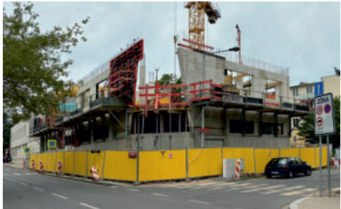
Při realizaci hrubé stavby je již dobře patrná nepravidelná forma objektu.
