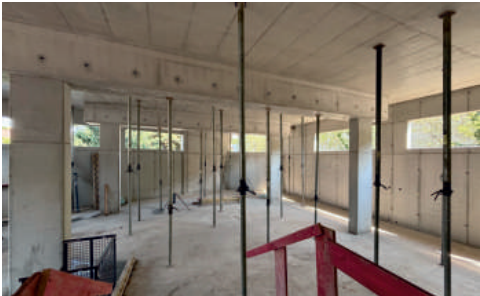
Pohledové provedení betonových konstrukcí vyžaduje pečlivý postup.
