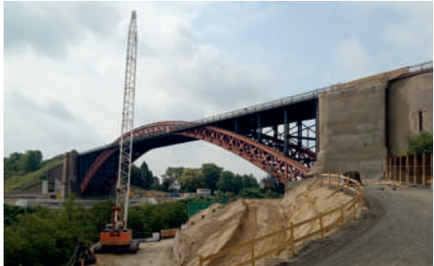
Před vrtáním pilot pro severní opěru mostu v Kielu je třeba stabilizovat svah.
