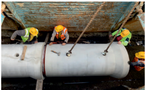
Pro manipulaci s rozměrnými kanalizačními prefabrikáty musela být nasazena mechanizace.
