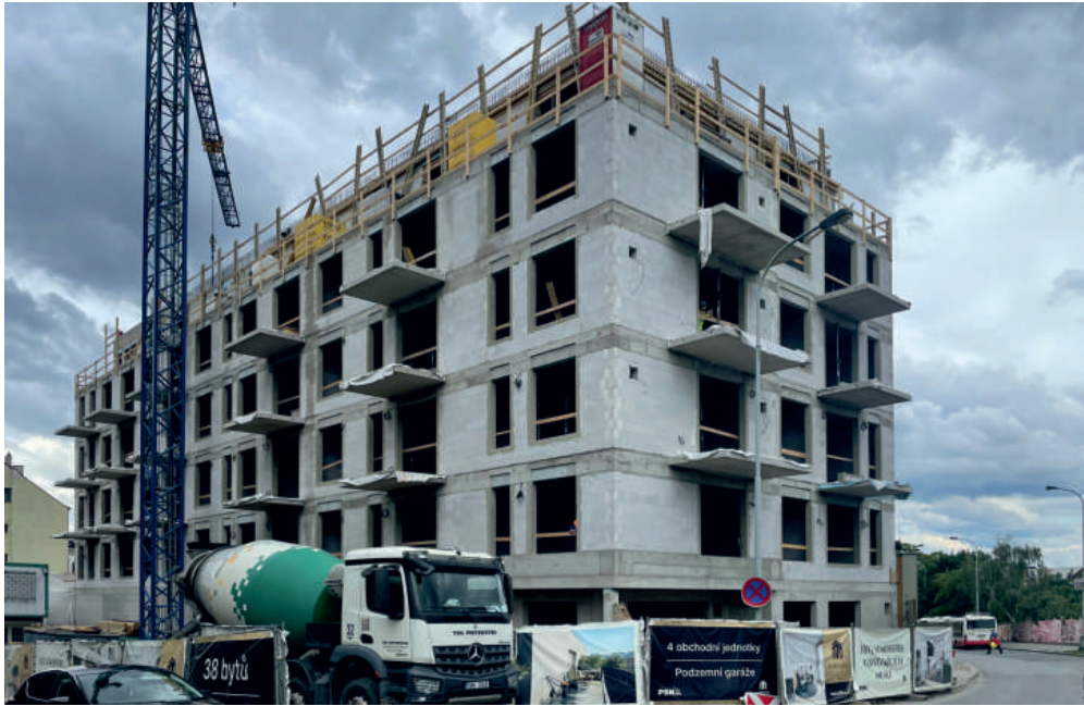
Hrubá stavba Rezidence Maroldka je téměř dokončena. Bytový dům má šest nadzemních podlaží včetně jednoho ustoupeného, plochá střecha bude sloužit jako terasa.
