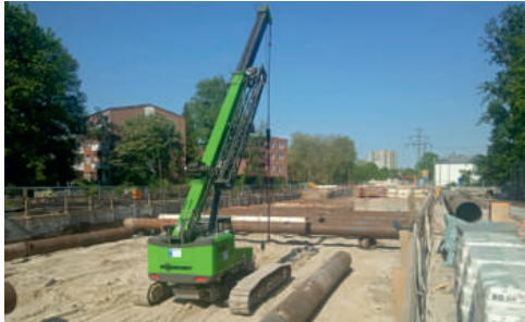
Stěny stavební jámy pro hloubení metra v Hamburku zajišťují ocelové rozpěry.
