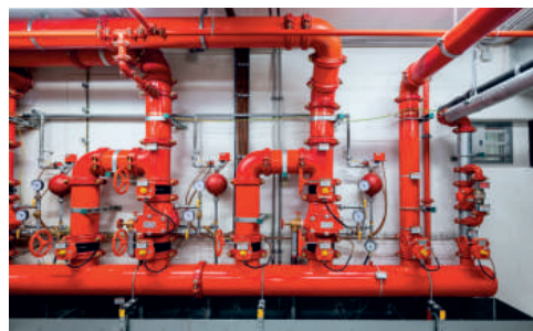
Zakázka zahrnovala také instalaci stabilního hasicího zařízení.
