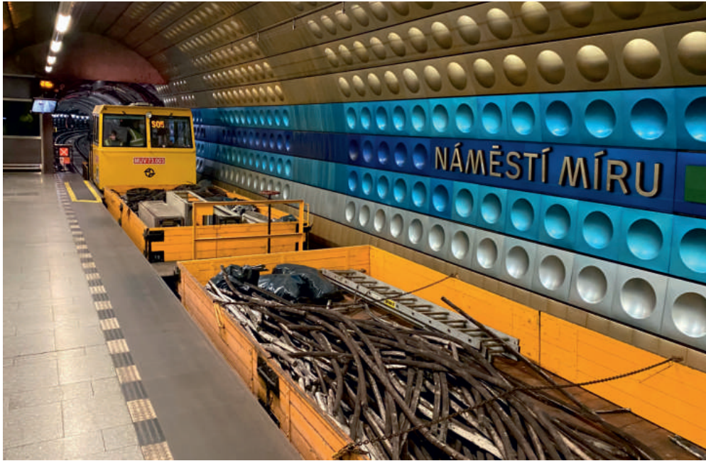
Výměna osvětlení a kabelů v traťových tunelech mezi stanicemi Náměstí Míru, Jiřího z Poděbrad, Flora a Želivského si vyžádala přepravu velkého množství materiálu.
