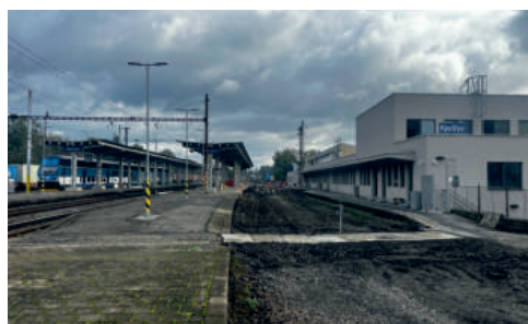
V úvodní fázi modernizace havířovské stanice byly sneseny některé koleje.
