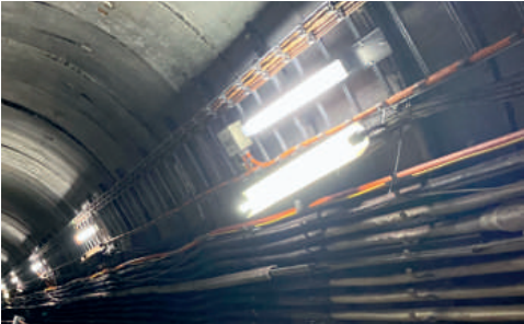
Zastaralá a energeticky náročná trubcová svítidla nahradily úsporné LED zdroje.
