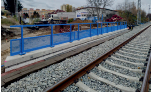
Přes dokončenou část mostu jezdí vlaky od začátku letošního roku.
