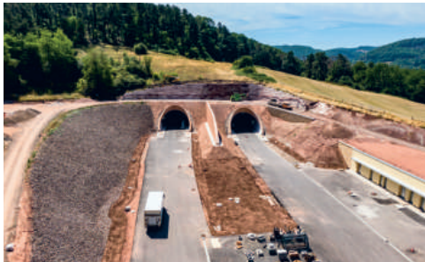
V oblasti severního portálu se nachází další součást stavby, odřez svahu Lerchenberg.
