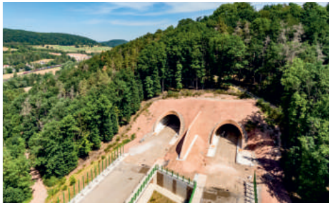
Tunel prochází pod zalesněným západním úpatím hory Spitzenberg v obci Wehretal.
