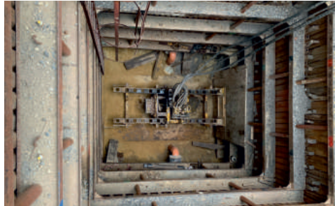
Potrubí bylo protlačováno v hloubce přesahující osm metrů.
