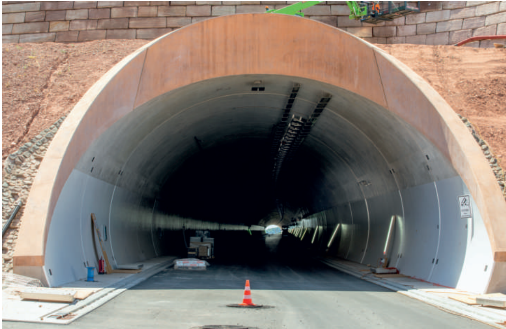
Tunel Spitzenberg tvoří dva dvoupruhové tubusy téměř 600metrové délky, dvě propojky a také přibližně půlkilometrový navazující úsek dálnice A44.
