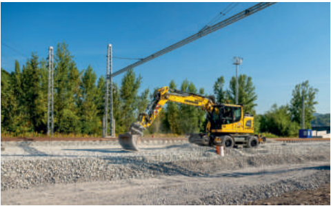
Při přestavbě nádraží se rozsáhle uplatňují rovněž dvoucestná rýpadla.
