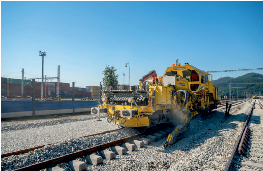
Vedle protihlukových stěn buduje divize 3 v Žilině především koleje, při jejichž realizaci bývá opakovaně nasazována vlastní mechanizace, například pluh pro úpravu kolejového lože.
