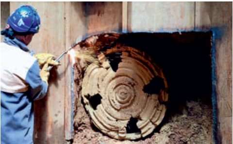
Ve štetovnicovém pažení bylo třeba vyřezávat prostor pro razící štít.
