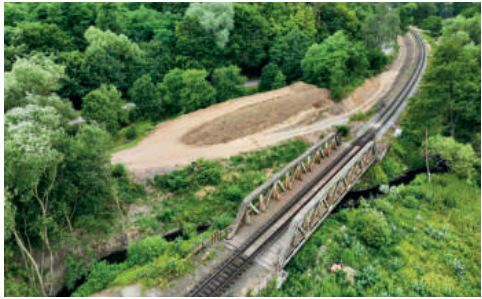
Součástí stavby je také rekonstrukce mostů, propustků a dalších objektů.
