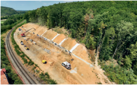
Přestavba úseku na dvojkolejnou trať vyžaduje výrazné terénní úpravy.
