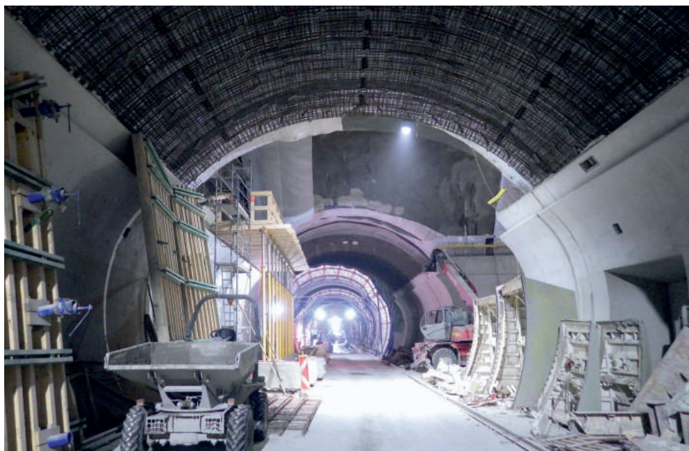
V místě spojení hlavního tubusu a vzduchotechnické kaverny je profil tunelu největší, betonáž sekundárního ostění proto vyžadovala atypické bednění.
