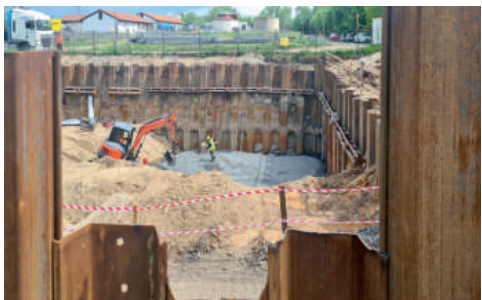
Stavba nádrží a dalších objektů vyžaduje objemné zemní práce.
