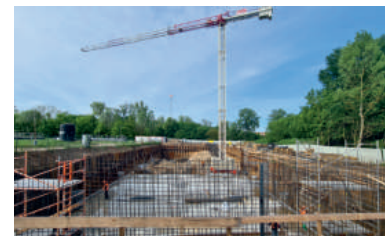
ČOV V BRANDÝSE NAD LABEM
