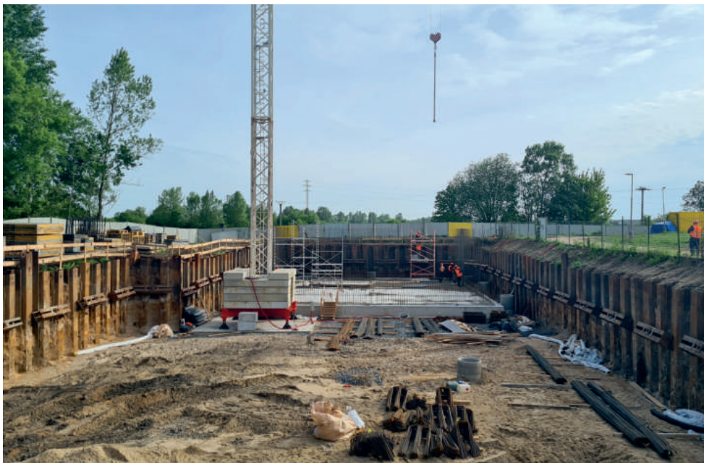
Přeměna čistírny odpadních vod v středočeském dvojměstí představuje rozsáhlý projekt, který bude divize 2 realizovat ve třech etapách ještě tři roky.
