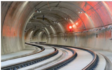
Návštěvníkům se naskytl nezvyklý pohled na vnitřek tunelu z horizontu chodce.
