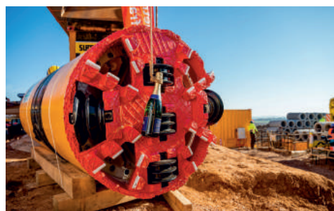
Štít je nasazen na ražbu kanalizace, která se nachází v hloubce až devíti metrů.
