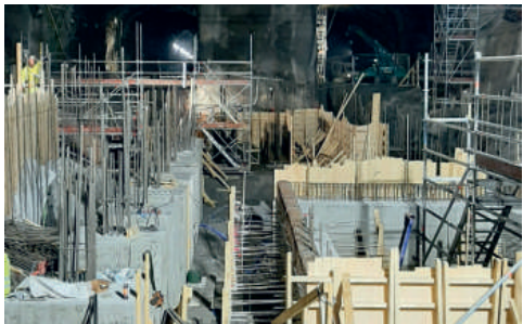
V prostorách stanice Barkarbystaden jsou betonovány základové konstrukce.
