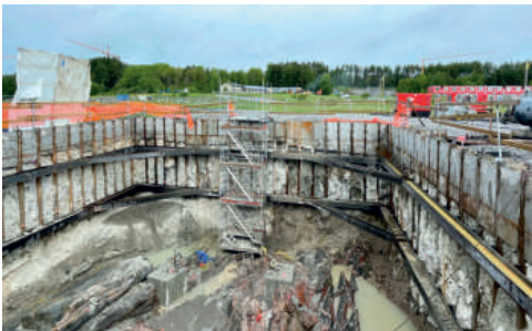
Pro rozpojování horninového masivu slouží také řezání diamantovými lany.
