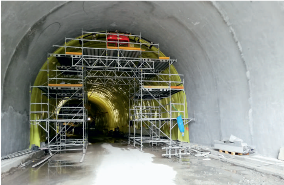
Pro opravu Blanenských tunelů využila divize 1 například cementové a chemické injektáže, stříkaný beton a sanační stěrky. Hydroizolační vrstvu na dvou ze čtyř tunelů tvoří fólie.
