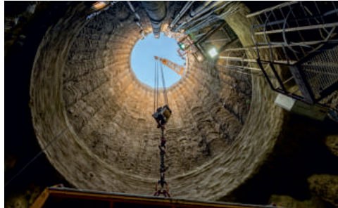
Při výstavbě stanice Pankrác D bude využita stávající těžní šachta.
