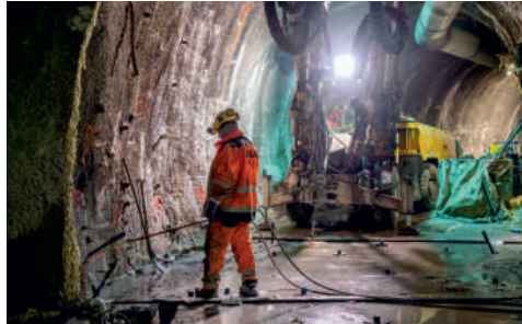
Před zahájením ražby bylo třeba horninu zpevnit chemickými injektážemi.
