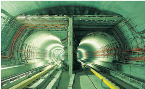
Ražený úsek je z převážné části dvoukolejný, rozpletá se 200 metrů před stanicí Kobylisy.
