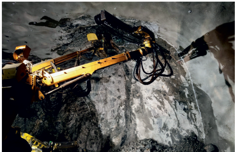
Ražby v tvrdém žulovém masivu jsou realizovány skandinávskou metodou „Drill and Blast“ spočívající v navrtávání horniny a odstřelu emulzní trhavinou. Ostění zajišťují převážně kotvy a stříkaný beton.
