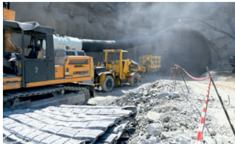
Pro rozpojování horniny jsou využívány také trhací práce.
