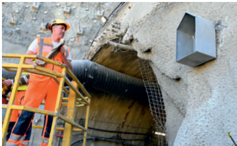
Patronka pracovníků v podzemí byla osazena do schránky na severním portálu.
