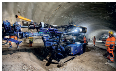
Vysoké přítoky vod v pásnu poruch vyžadují speciální technologii pro odvodňovací vrty.
