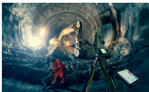
V některých úsecích tunelu muselo být dno uzavřeno raženou protiklenbou.
