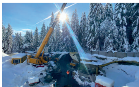
Unikátní větrací šachtu se v horském terénu podařilo vyhloubit za pět měsíců.
